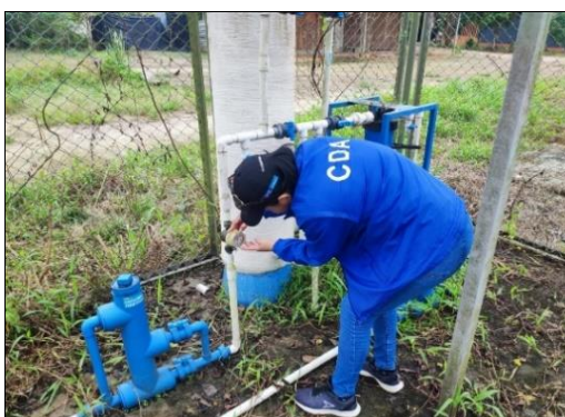
Foto No.9 Seguimiento a concesión de aguas CAS-00003-20 Fuente: Archivo propio CDA
