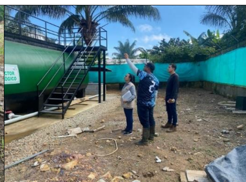
Foto No.10 Seguimiento a permisos de vertimientos - constructora e inversiones Orión SAS, con PTAR Fuente: Archivo propio CDA
