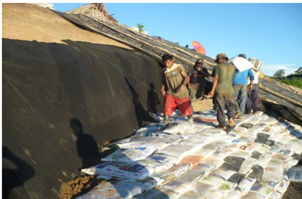
Protección de taludes
