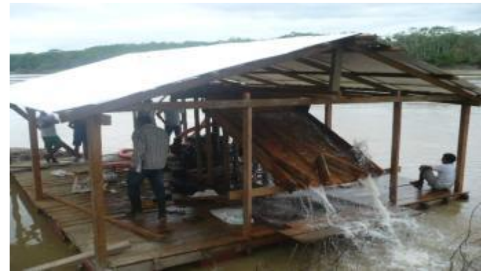
Armado de Barcaza para explotación del material del Río
