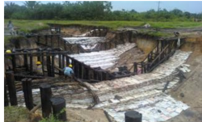
Estructura Transversal carcava 3
