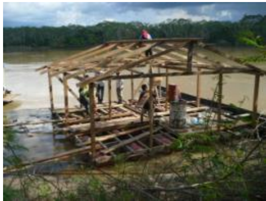
Armado de Barcaza para explotación del material del Río
