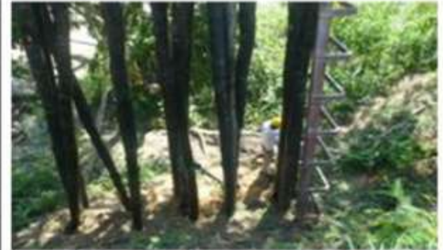
Hincado de Pilotes - Cárcava No. 2
