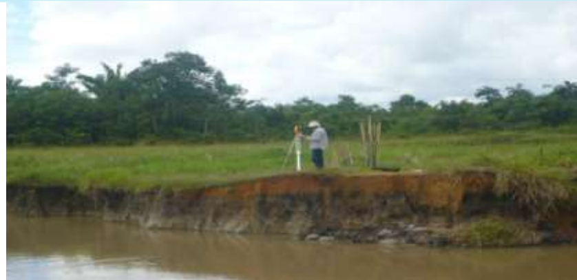
Levantamiento de las cunetas de coronación
