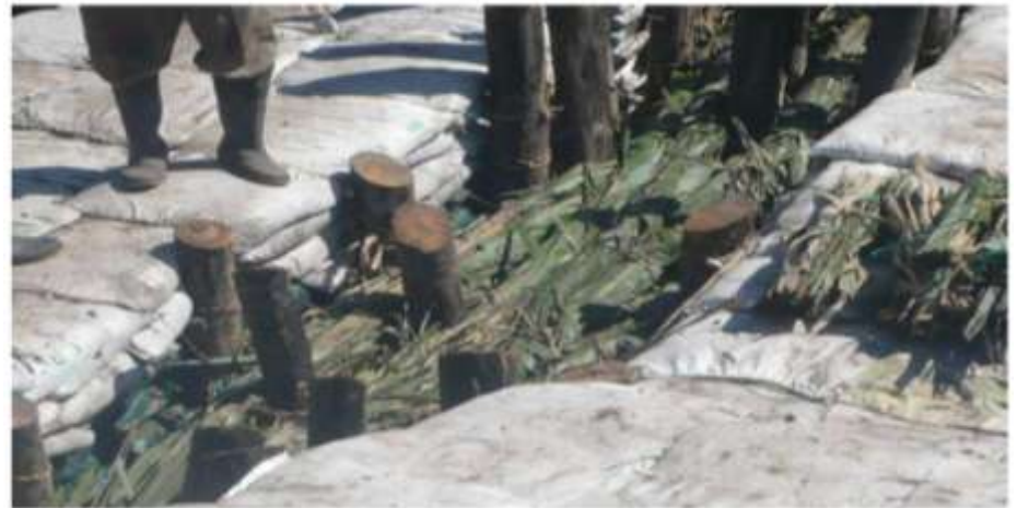
FOTO No. 4. Colocación de fajinas dentro de la estructura transversal.
