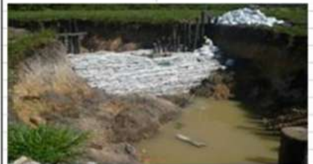
Colocacion de Bolsas-Suelo aguas debajo de la Estruct. Transversal.
