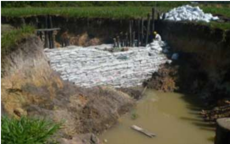
FOTO No. 3. Construcción estructura transversal (Trincho) cárcava No. 3
