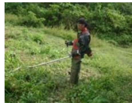
Asunto: Adecuación de terreno
