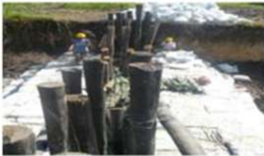
Colocación de fajinas. Estructura transversal. Trincho No. 2
