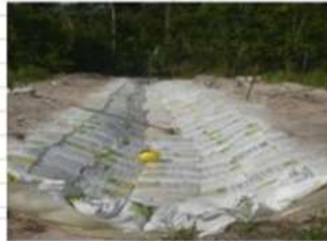
Tramo de cunetas revestido en Bolsa - Suelo
