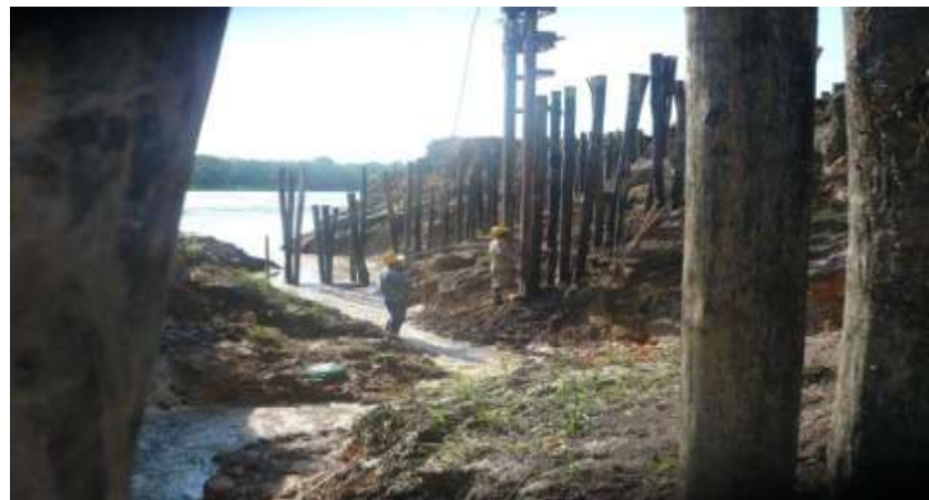
Hincado de Pilotes de Mader Cárcava No. 3 Sector de la Armada
