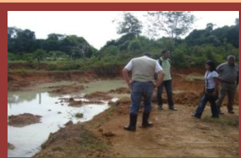
Control en zonas de cantera
