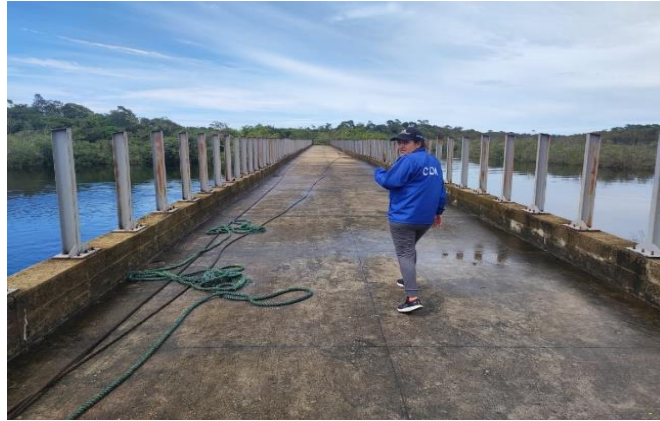
Descripción: Visita de Seguimiento OCA-00003-18 Lugar: Puente Pato / Fecha: 28 de junio de 2023 Responsable: Kimberly Dayana Escobar
