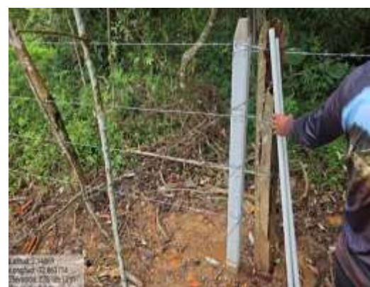
Texto resumen: Instalación de cercas Fecha: 18 de marzo de 2025 Identificación del lugar: Beneficiarios Foto tomada por: Técnico de campo
