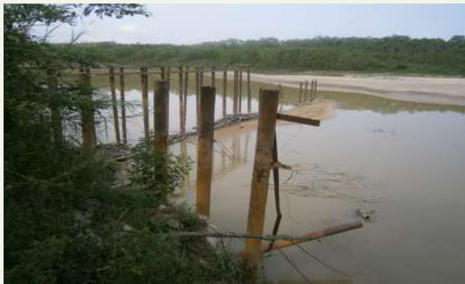
Foto 2 Obras de protección del meandro rio Guaviare.
