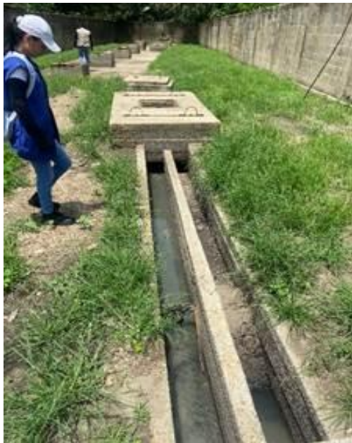
Imagen No. 18 Aliviadero
