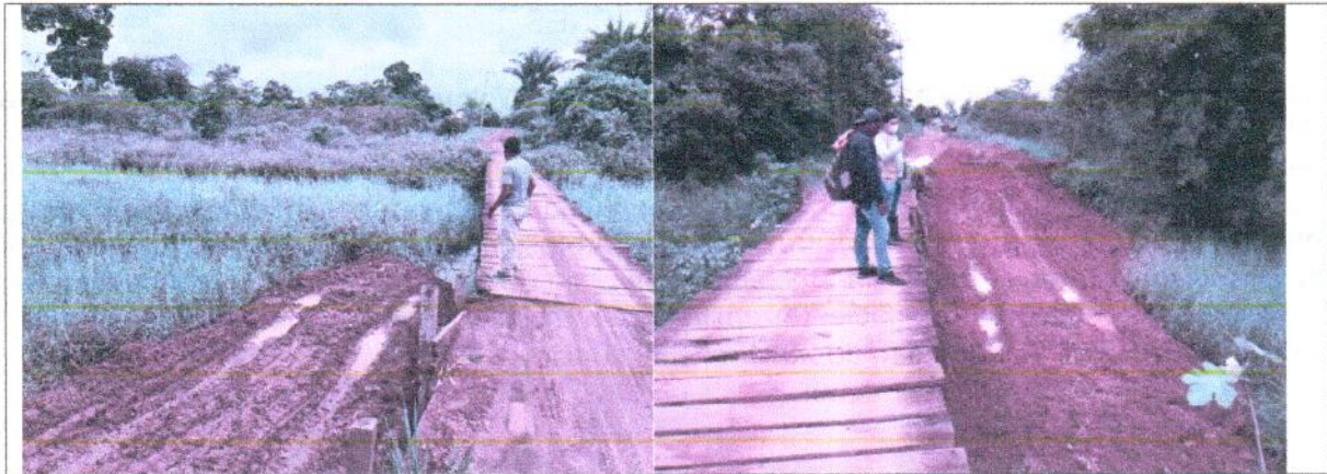
Imágenes del Relleno de Recebo dentro de la ronda del Caño Danta / Corroncho
