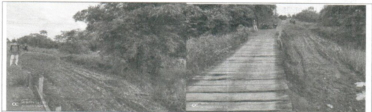
Imágenes del Relleno de Recebo dentro de la ronda del Caño Danta / Corroncho
