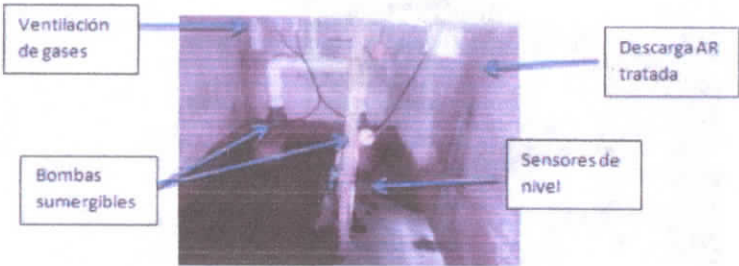
Imagen 7: Tanque de equilibrio agua residual domestica tratada
