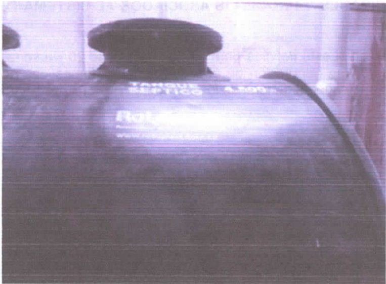
Imagen 2: Tanque séptico con filtro anaerobio Marca Rotoplas
