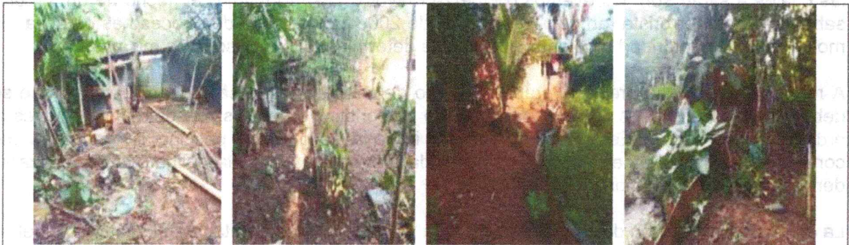
Imágenes en donde se aprecia el relleno del predio.
