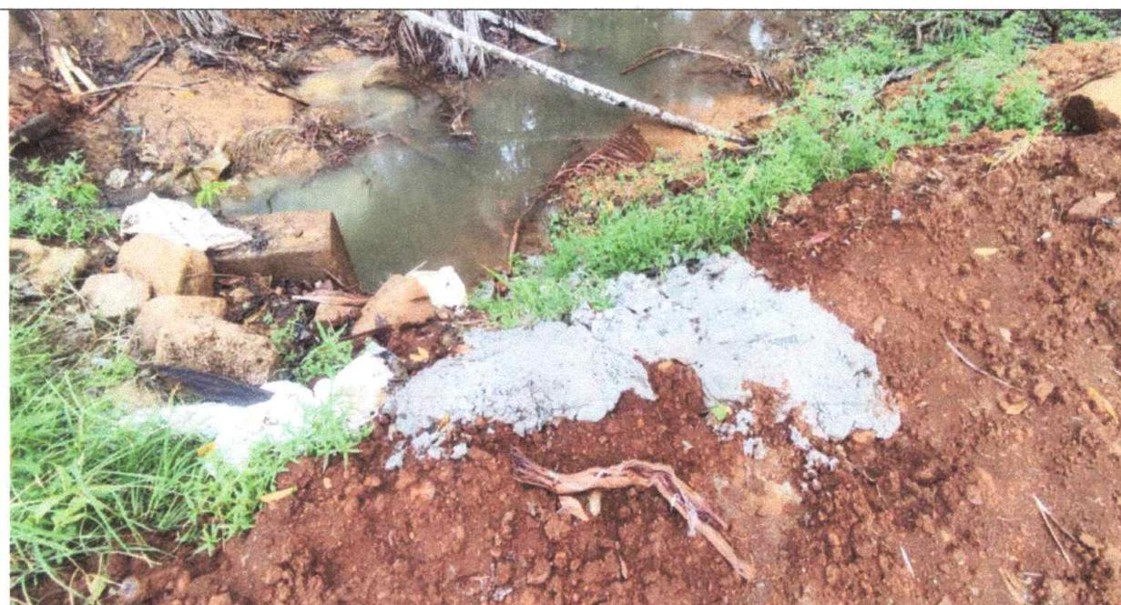
*Disposición inadecuada de residuos peligrosos material sobrante de obra "mezcla de concreto" en fuente hídrica y/o ronda hídrica*
