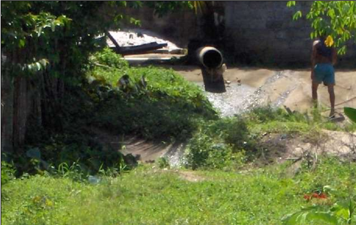
VERTIMIENTO TUBERÍA DE ALCANTARILLADO SOBRE CAÑO RAMÓN, ZONA INDÍGENA.
