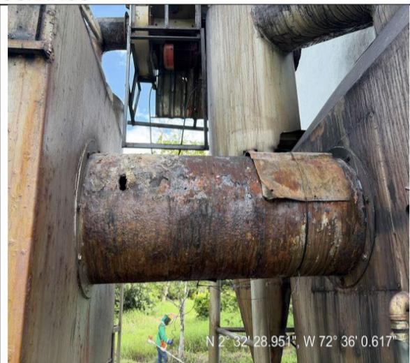
Imagen 2: Orificios en la estructura
